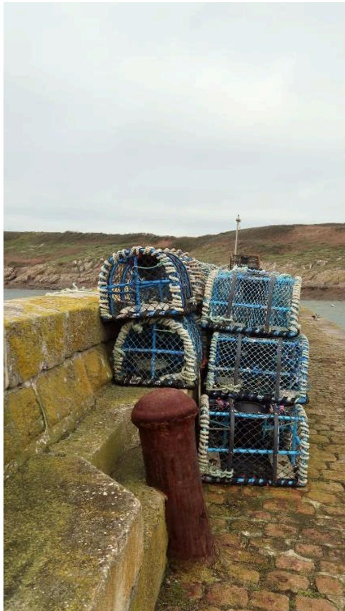
Môle Saint-Christophe : mises en oeuvre de la maçonnerie du parapet et de la plateforme, bollard et usage de rangement des casiers
