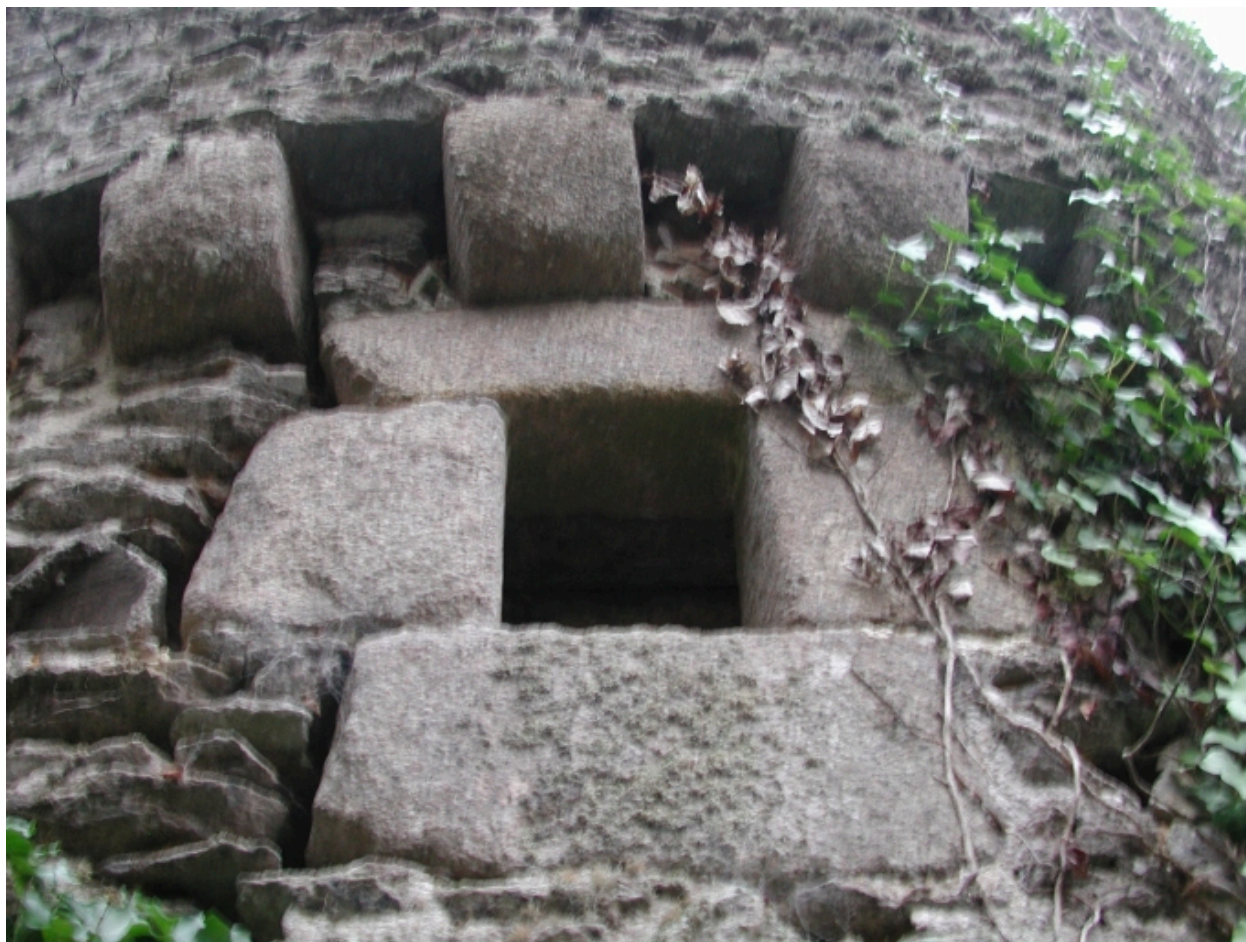
Vue d'une ouverture au-dessous de l'encorbellement en pierres de taille
