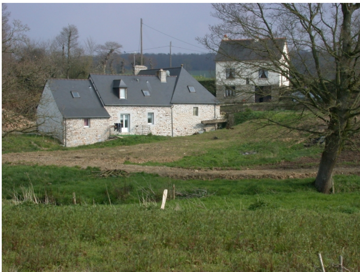
Vue générale ouest.
