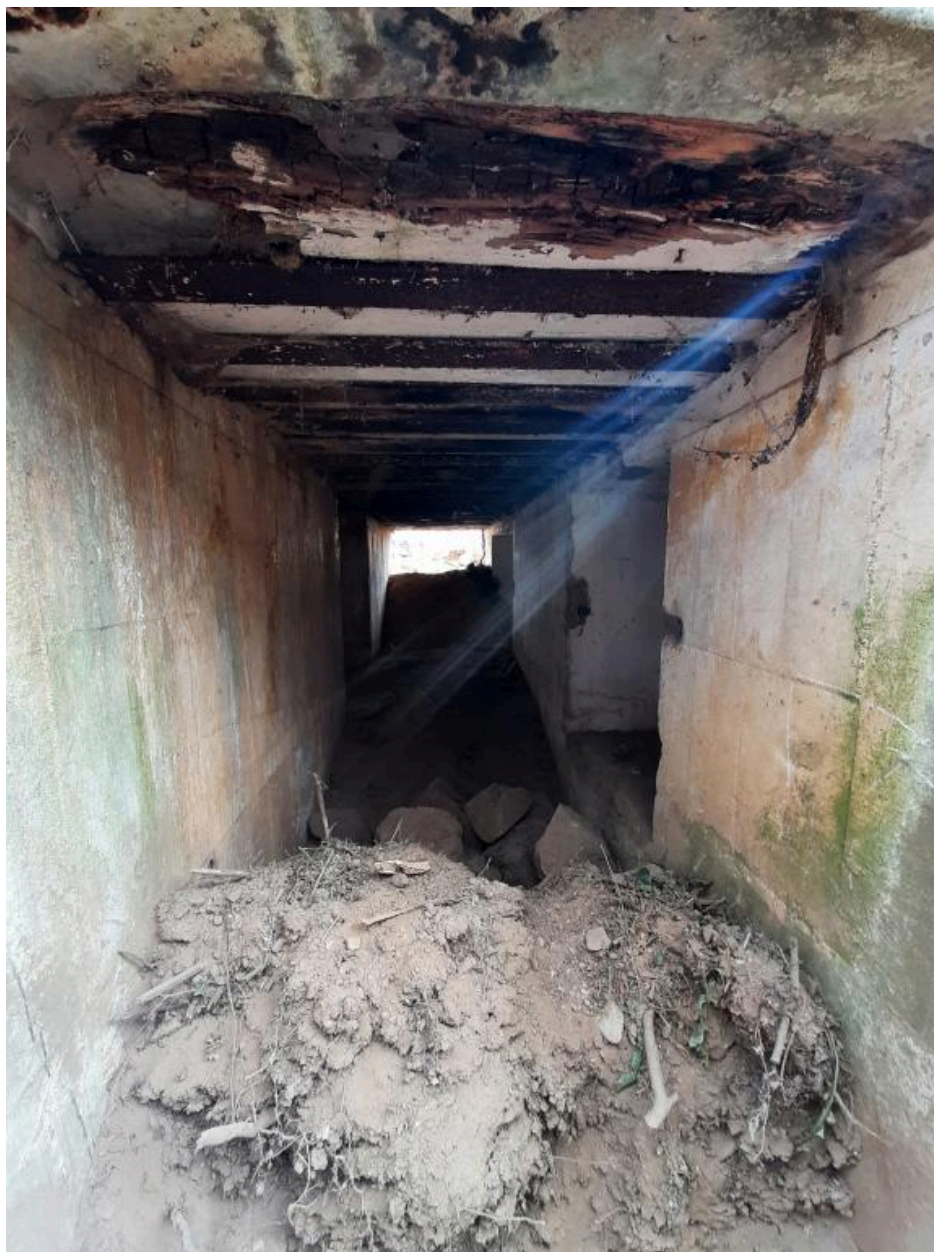
Vue de la déconstruction : couloir d'entrée (25 septembre 2022)
