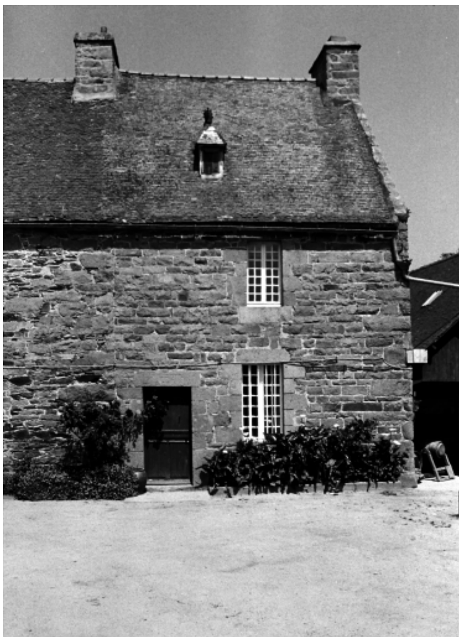
Corps de logis, élévation antérieure (cliché S. Laffiché, pré-inventaire, 1973)
