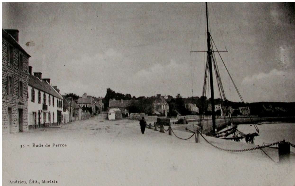
Vue générale des quais de la rade au temps du cabotage (collection particulière)
