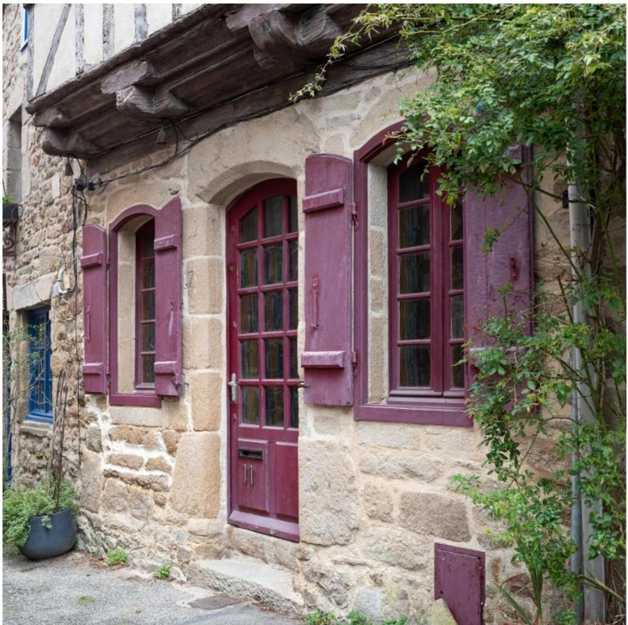
Rez-de-chaussée repris en sous-œuvre par une maçonnerie en 1816.
