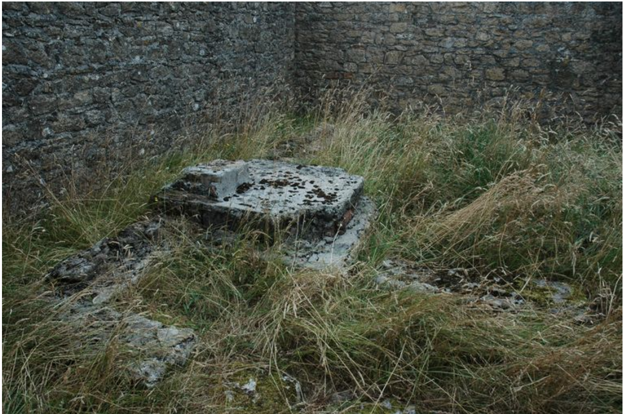
Vue de l'intérieur de la cuve : soubassement non identifié (état en 2003)
