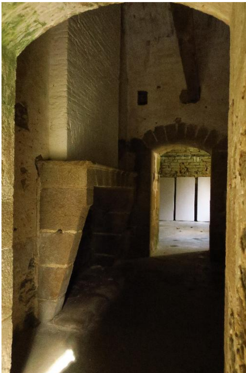
Le Palais, enceinte urbaine, réduit B, petite pièce de gauche.
