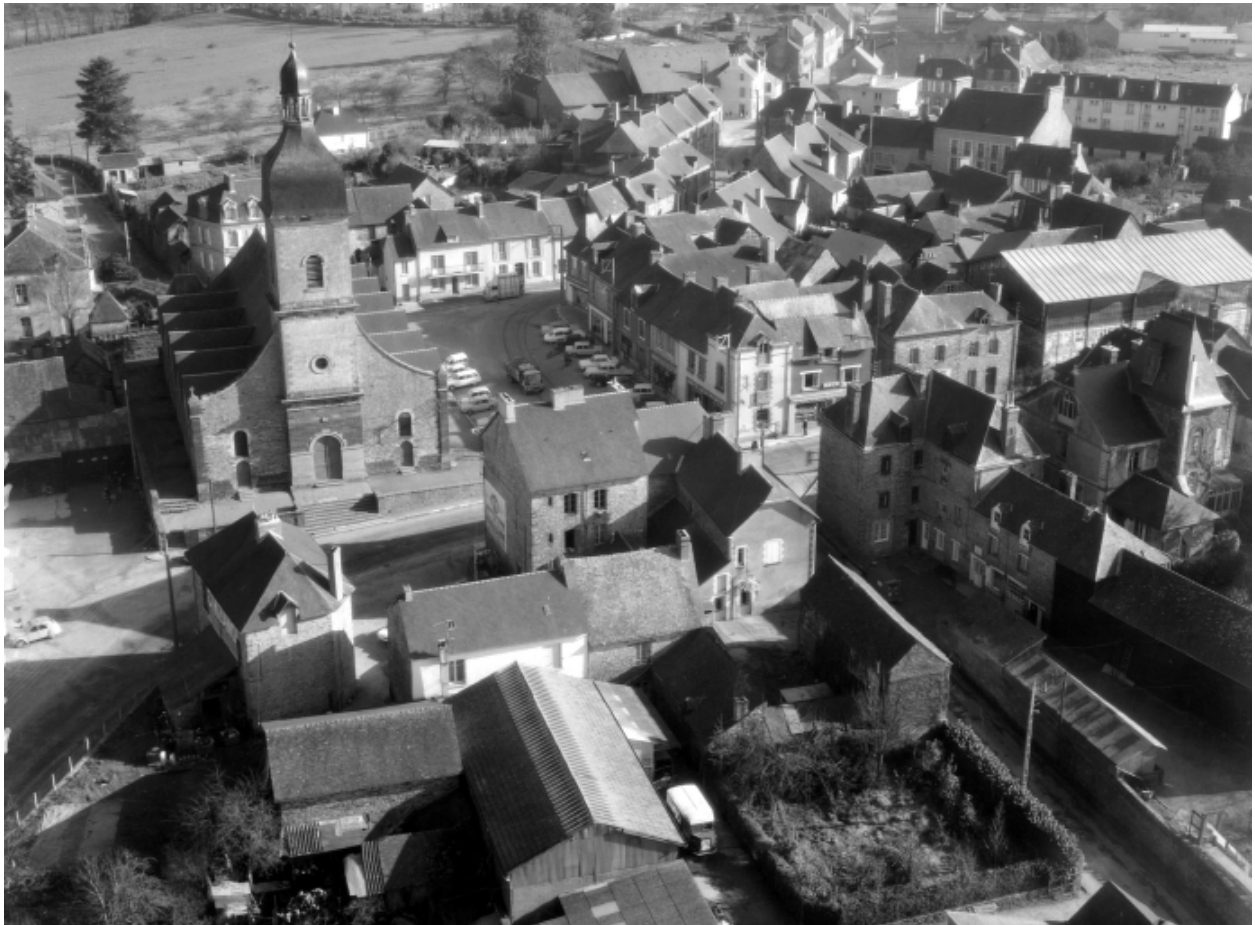
Elévation Ouest : vue aérienne
