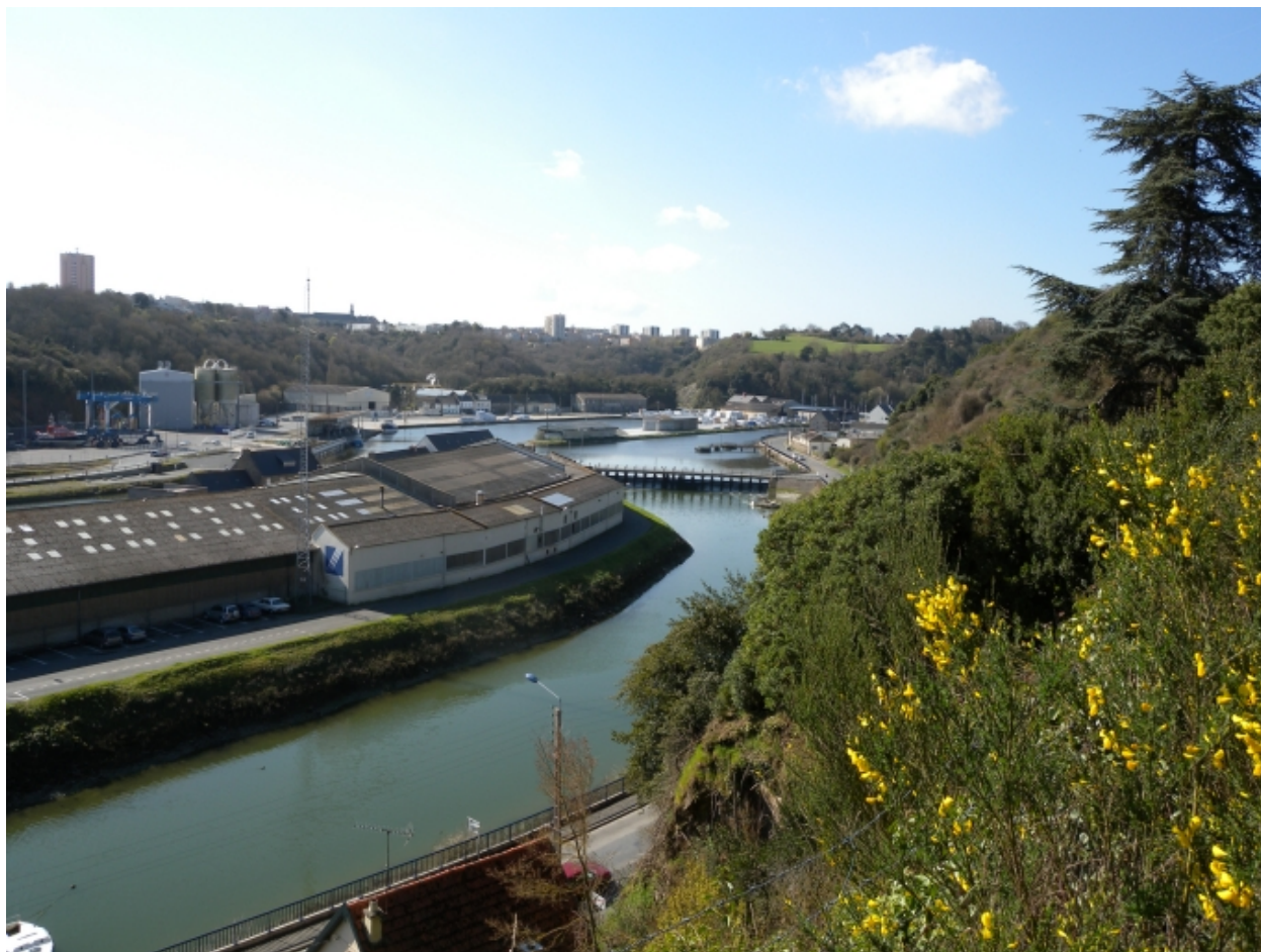
Vue de l'avant- port du Légué en aval du barrage-déversoir, à marée haute
