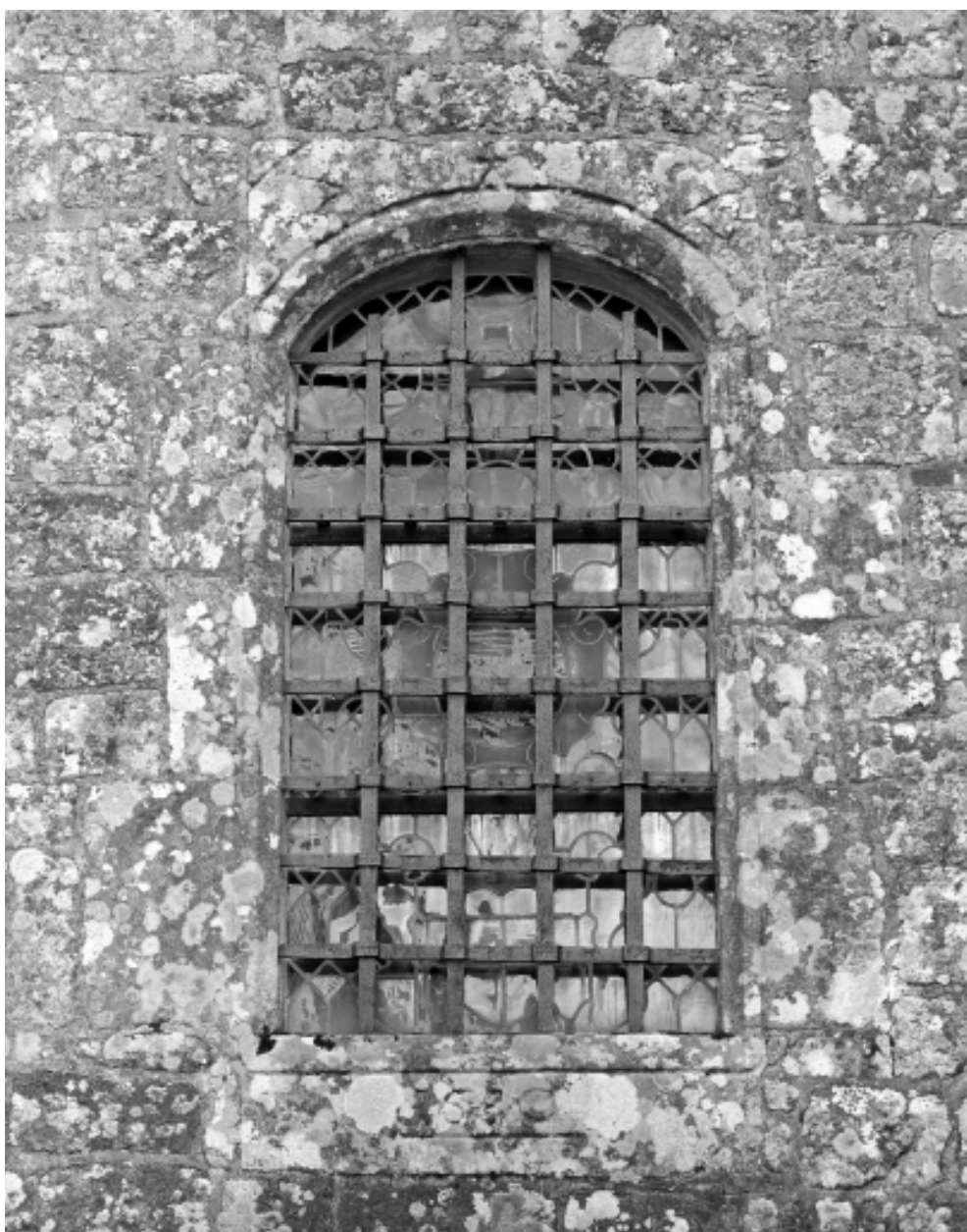
Elévation sud, fenêtre datée : vue générale.
