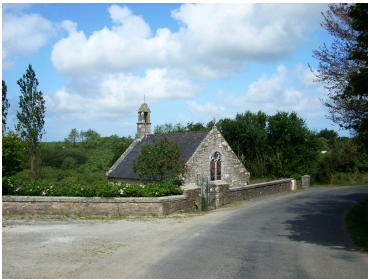
Kernouës, chapelle de la Clarté : vue générale sud-est
