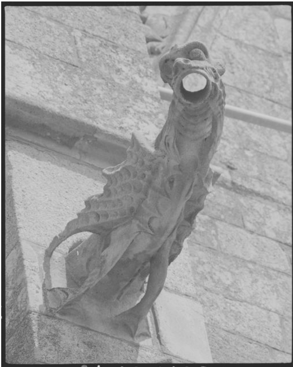
Gargouille, façade sud
