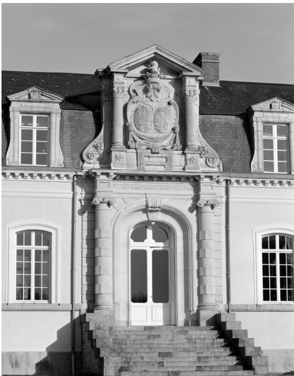
Elévation sud : partie centrale.
