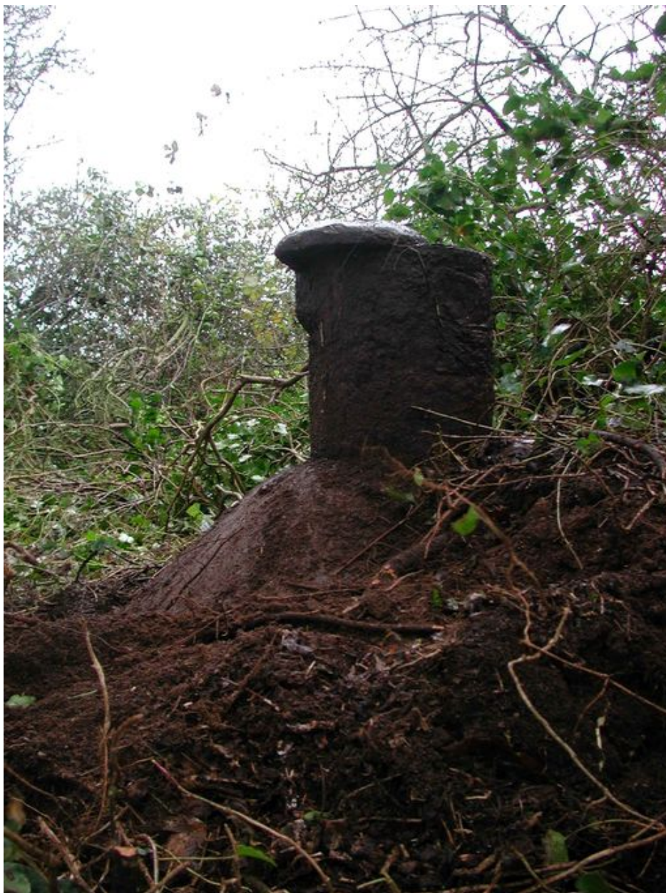
Vue du conduit du périscope avec son volet blindé
