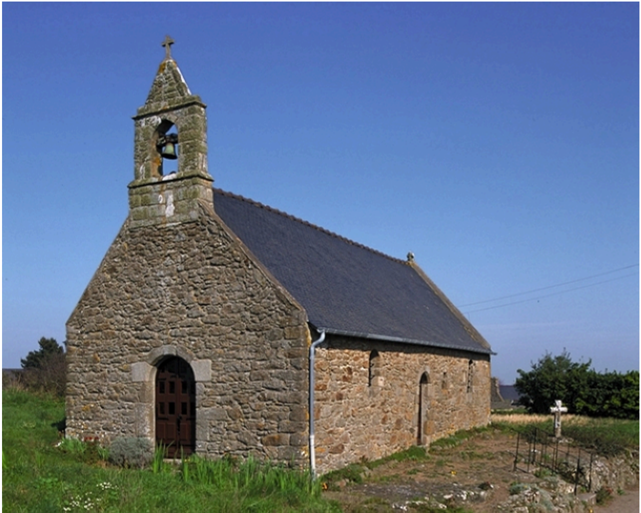
Vue générale sud
