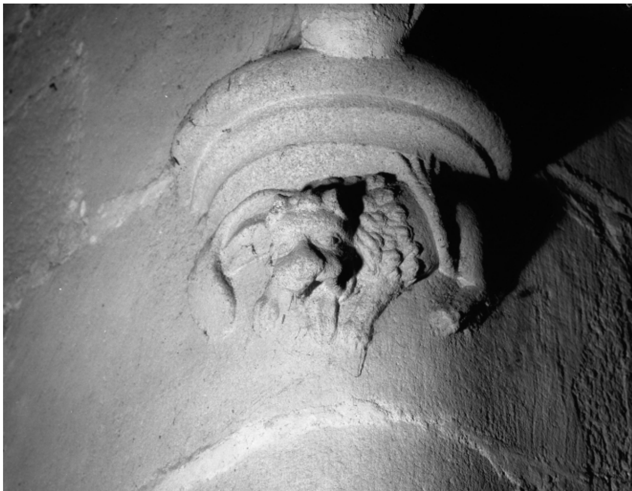
Escalier, 1er palier, croisée est : détail du cul-de-lampe nord ouest
