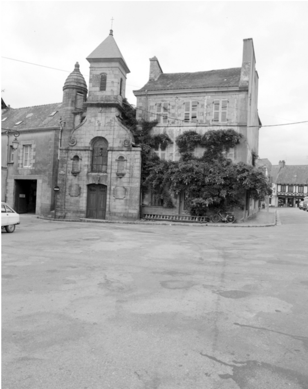
Vue générale de la façade principale sud.
