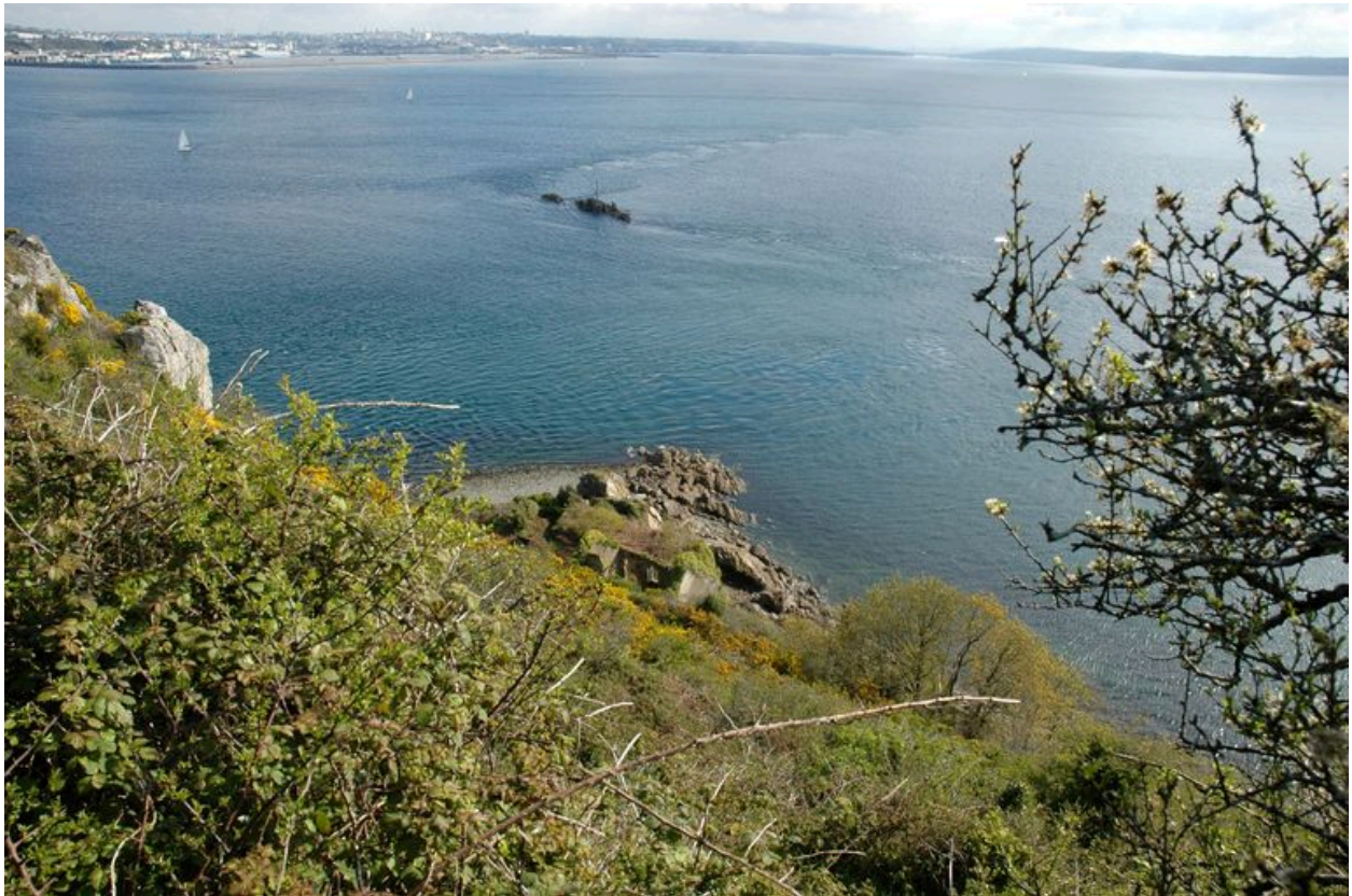
Vue de la pointe des Espagnols : la batterie basse et ses casernements ruinés
