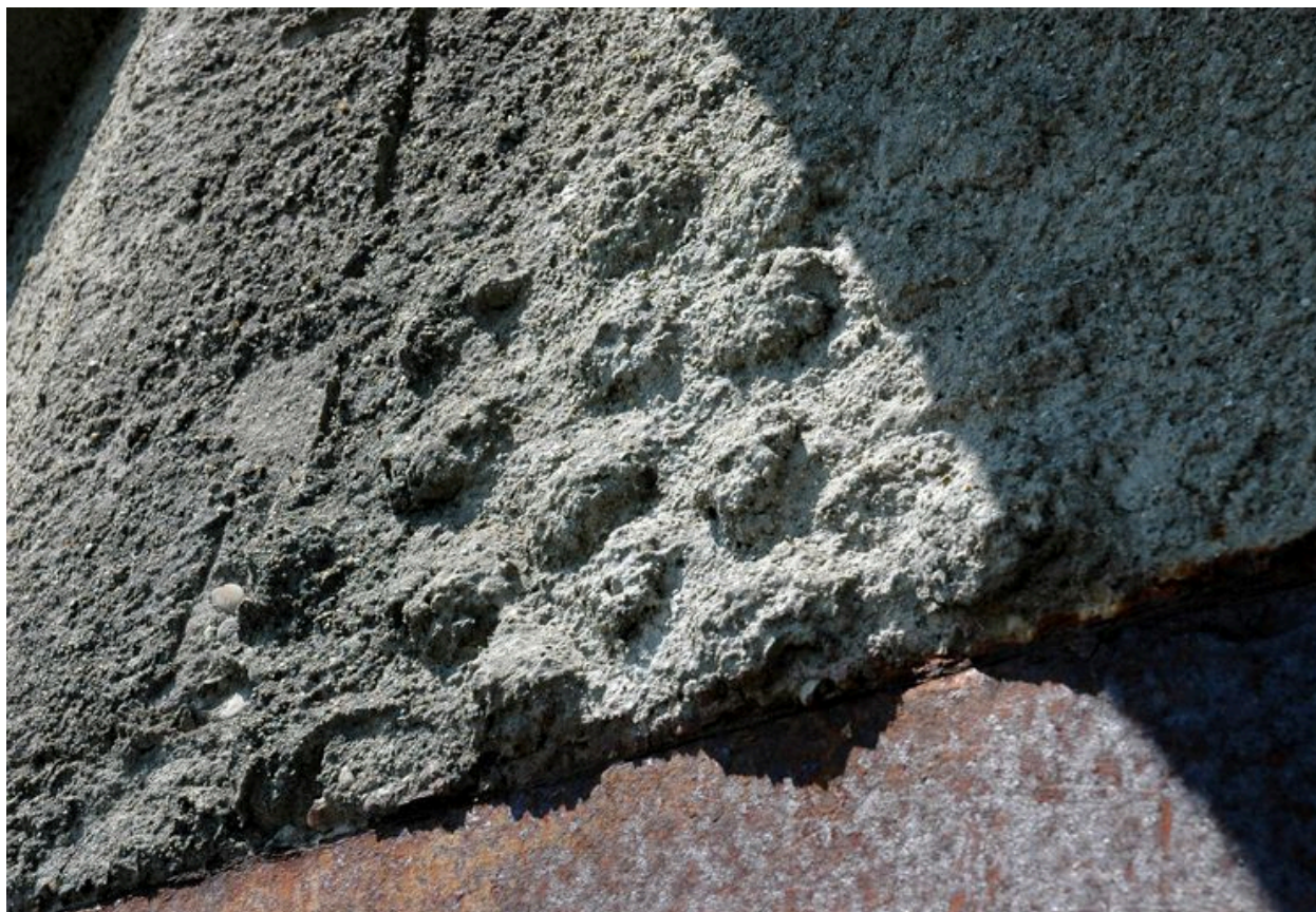
Vue de l'un des deux bunkers - casemates de type 671 (état en 2005). Le traitement du béton participait du camouflage du bunker
