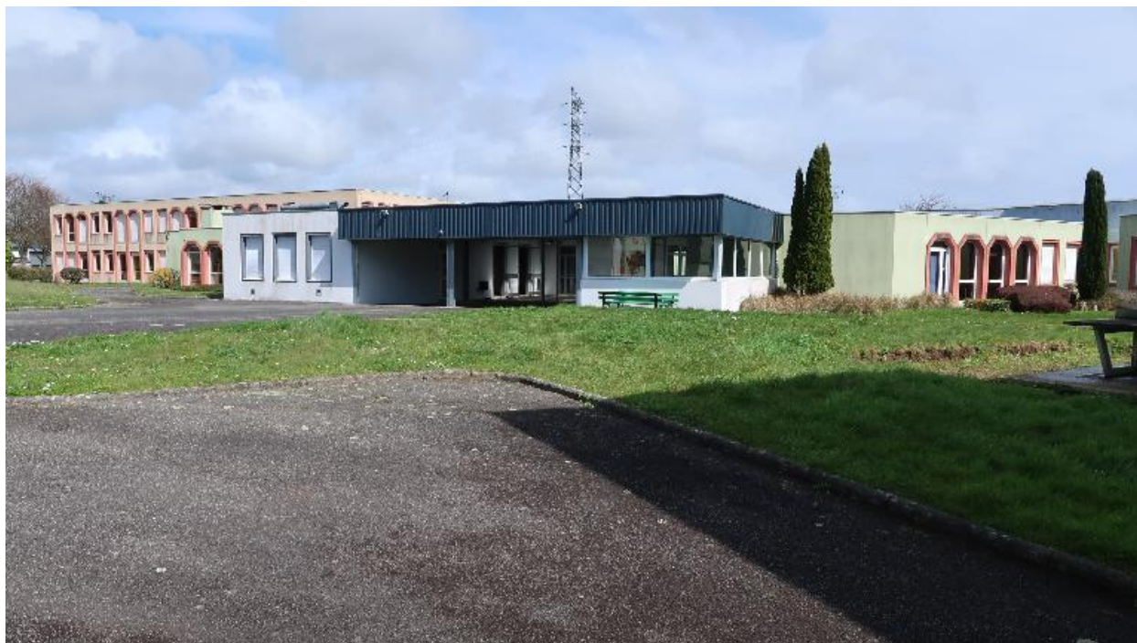
Vue générale prise de l'intérieur du lycée : administration, externat, préau...
