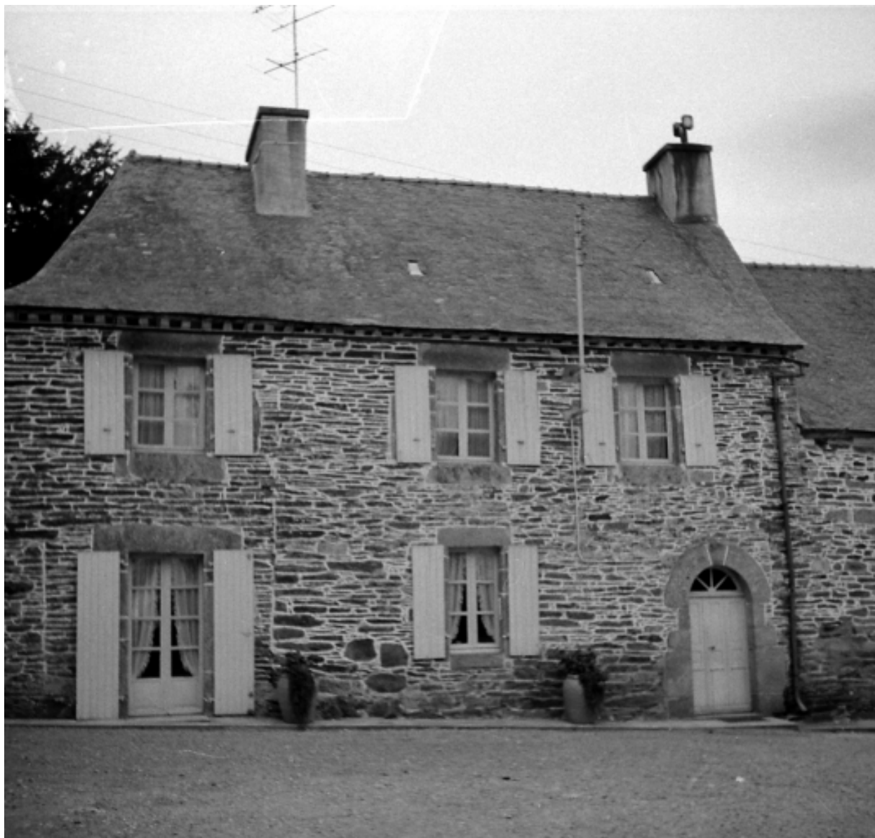
Logis gauche. Vue générale sud-ouest (état en 1969)
