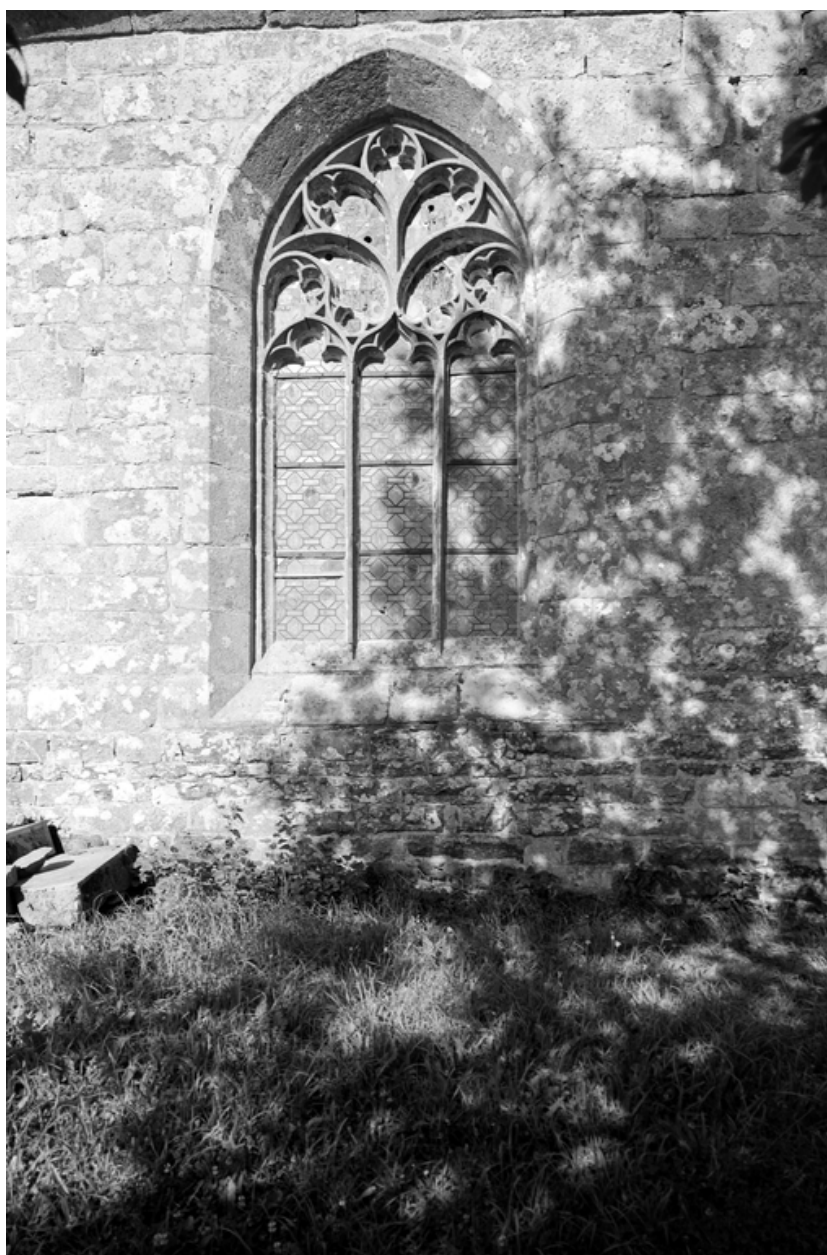
Fenêtre nord de la face est
