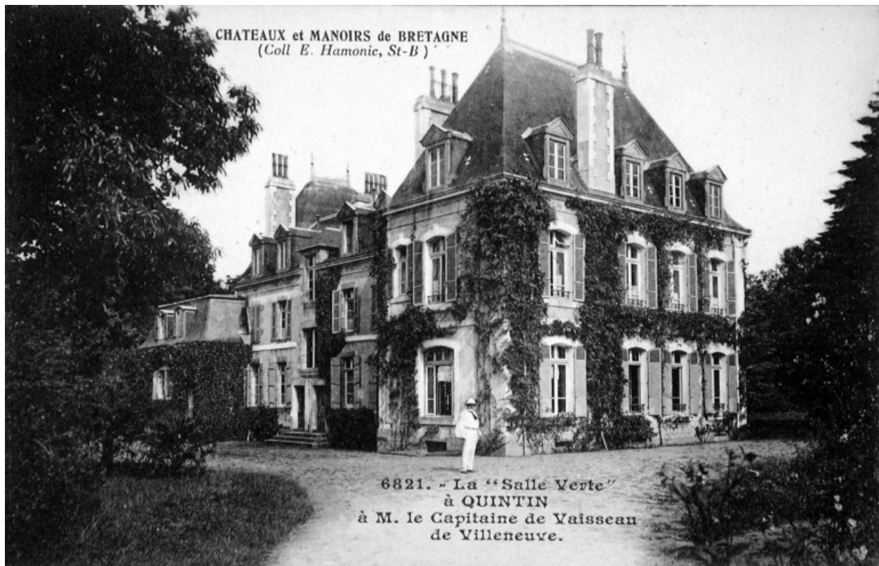
Vue générale de trois-quart
