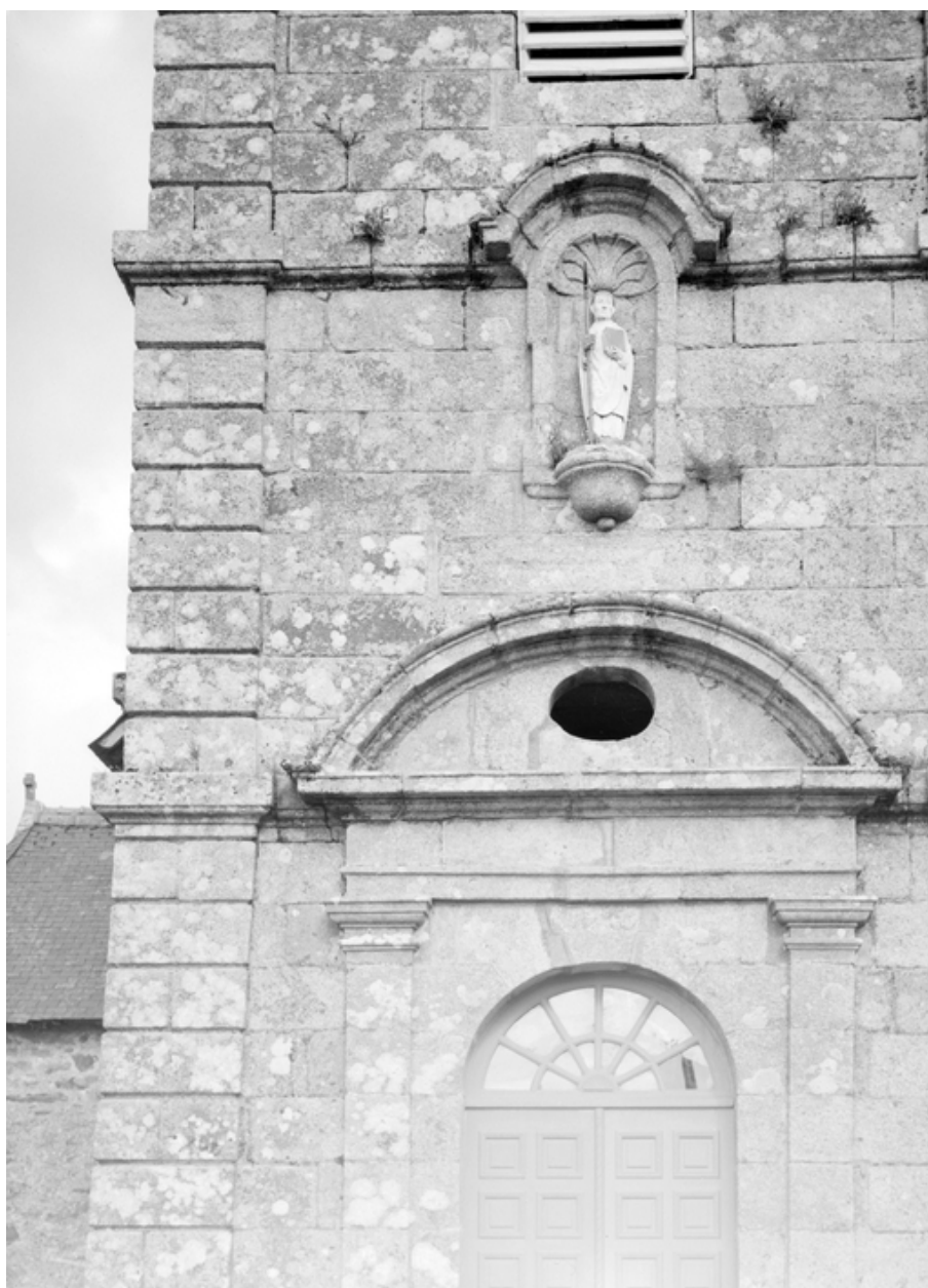
Détail de la façade
