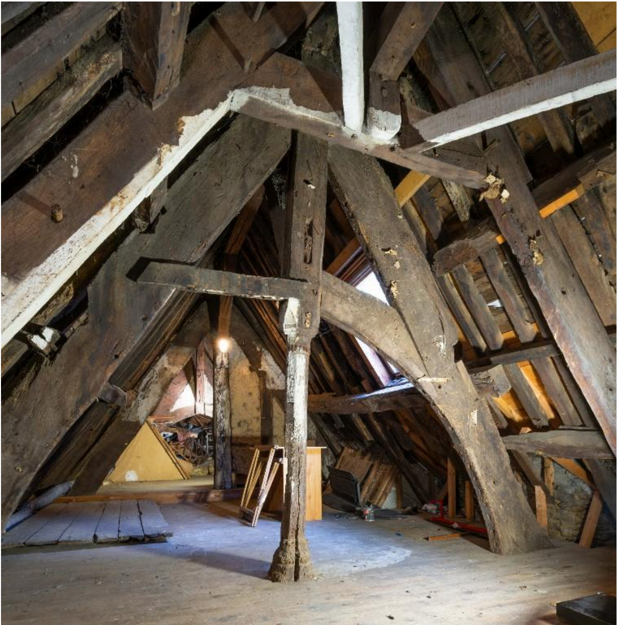
Alignement des fermes, vues depuis le sud. Deux d'entre elles sont de type armoricaine.
