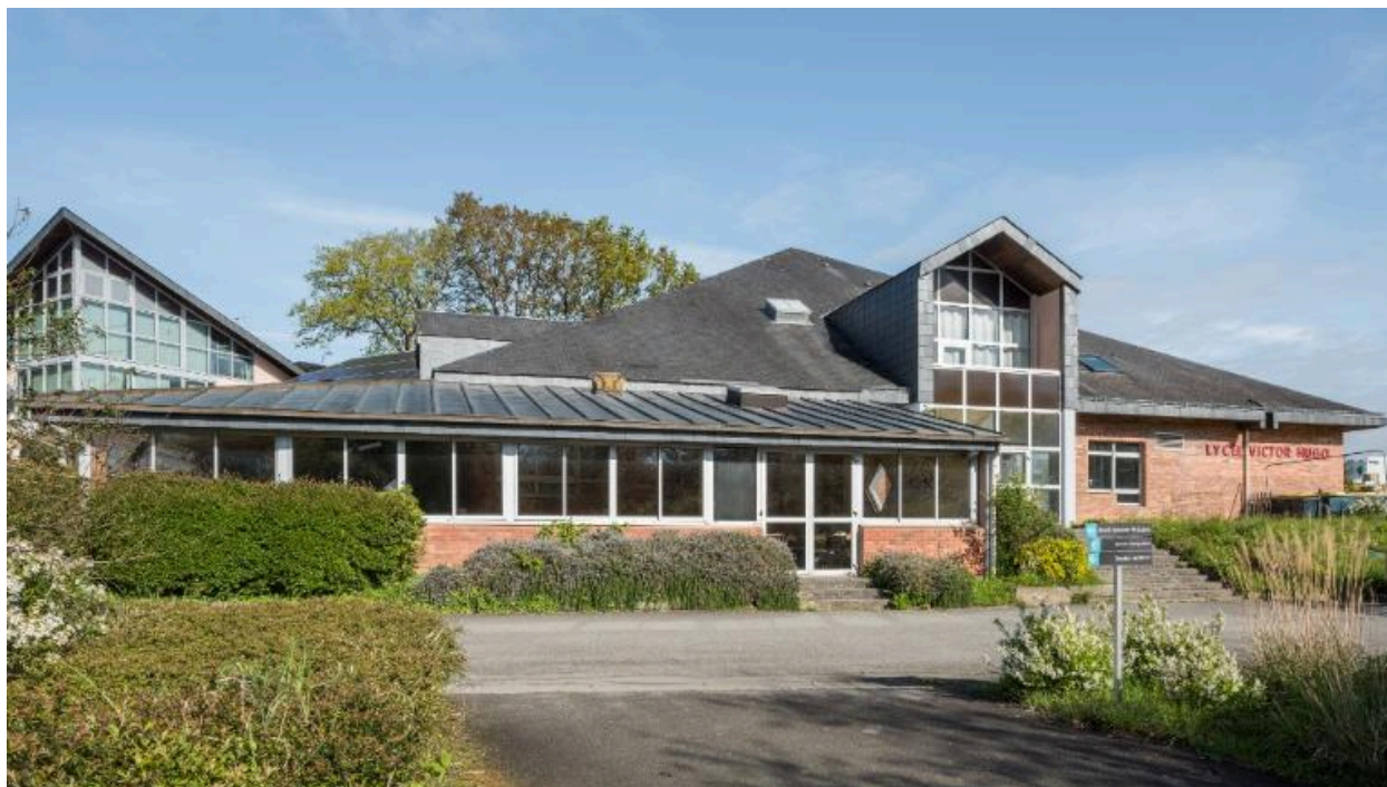
Vue d'ensemble des façade sud-est de l'aile jaune : restauration et externat. Patrick Pincemaille et Ruelland-Perche-Héraud, architectes, 1986.
