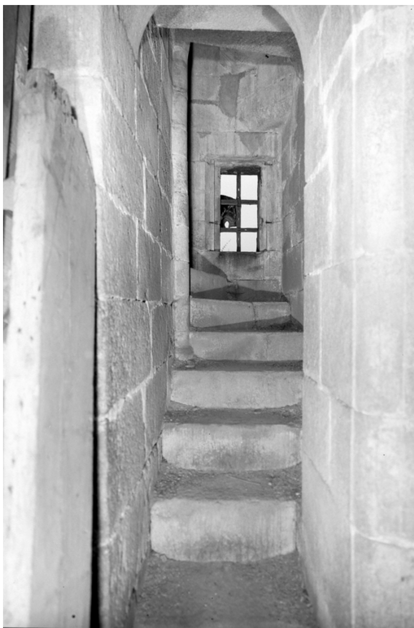
Sacristie : 2ème cage d'escalier, départ de la volée
