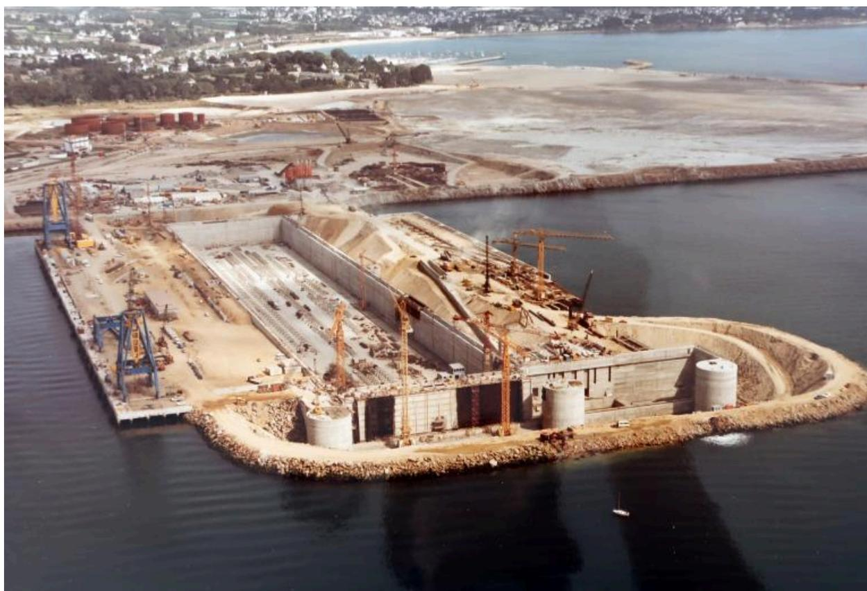
Installation des grues sur le QR4, radier et bajoyers de la forme, lignes de tins, têtes de forme avec emplacement du garage du bateau-porte, QR5 en cours de construction (septembre 1979)
