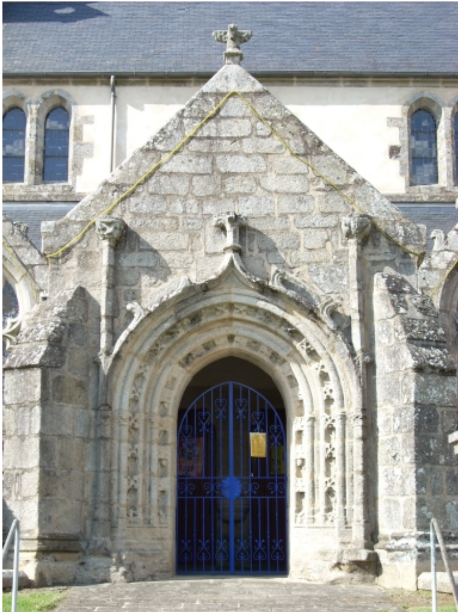
Ederne, église paroissiale Saint-Ederne : détail porche sud
