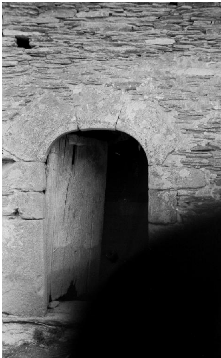
Ferme 26 : la porte (état en 1969)
