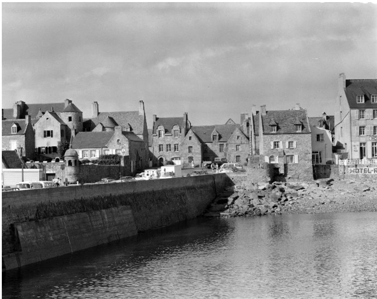
Corps de bâtiment nord, élévation nord, vue générale
