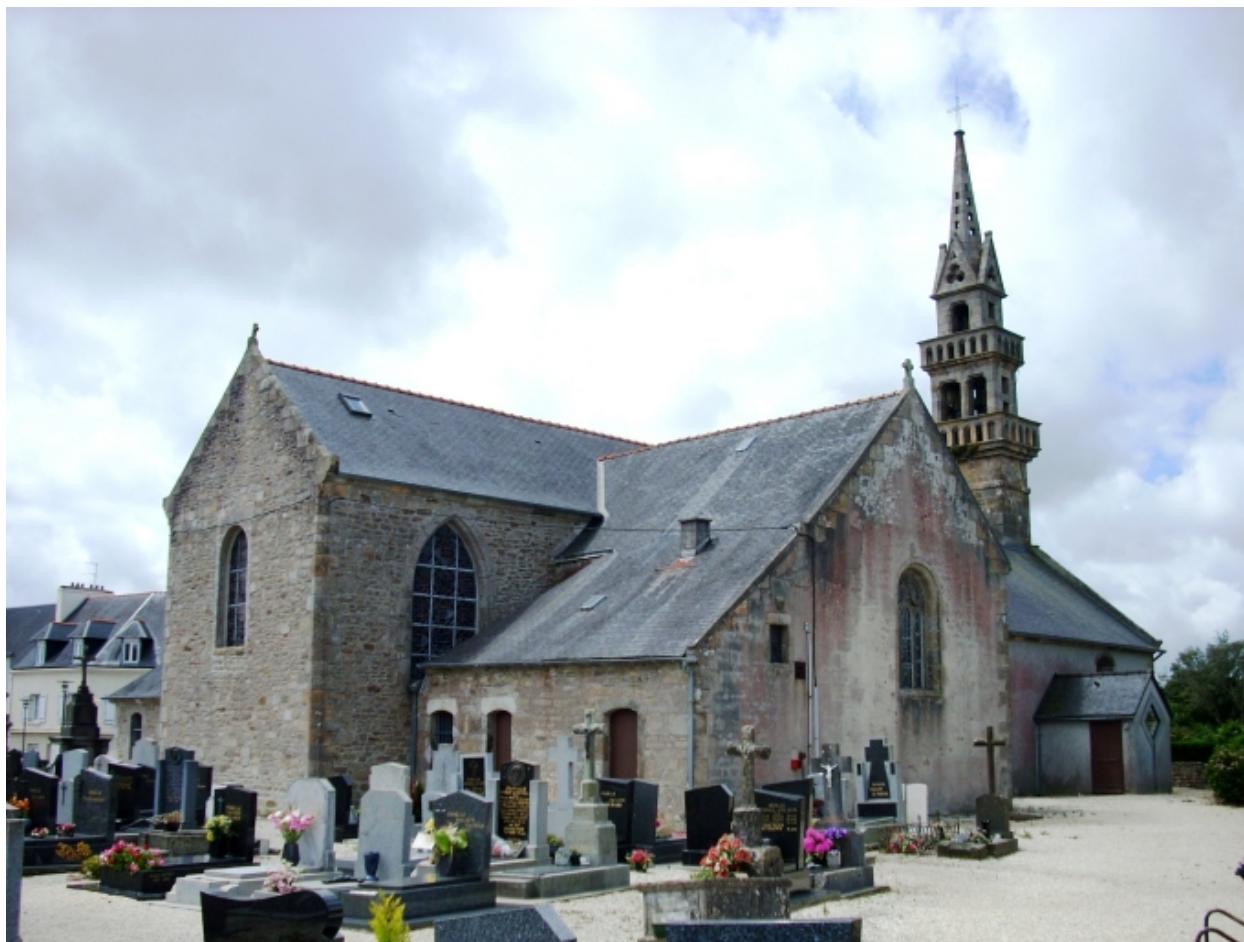
Guilers, église paroissiale : vue générale nord-est
