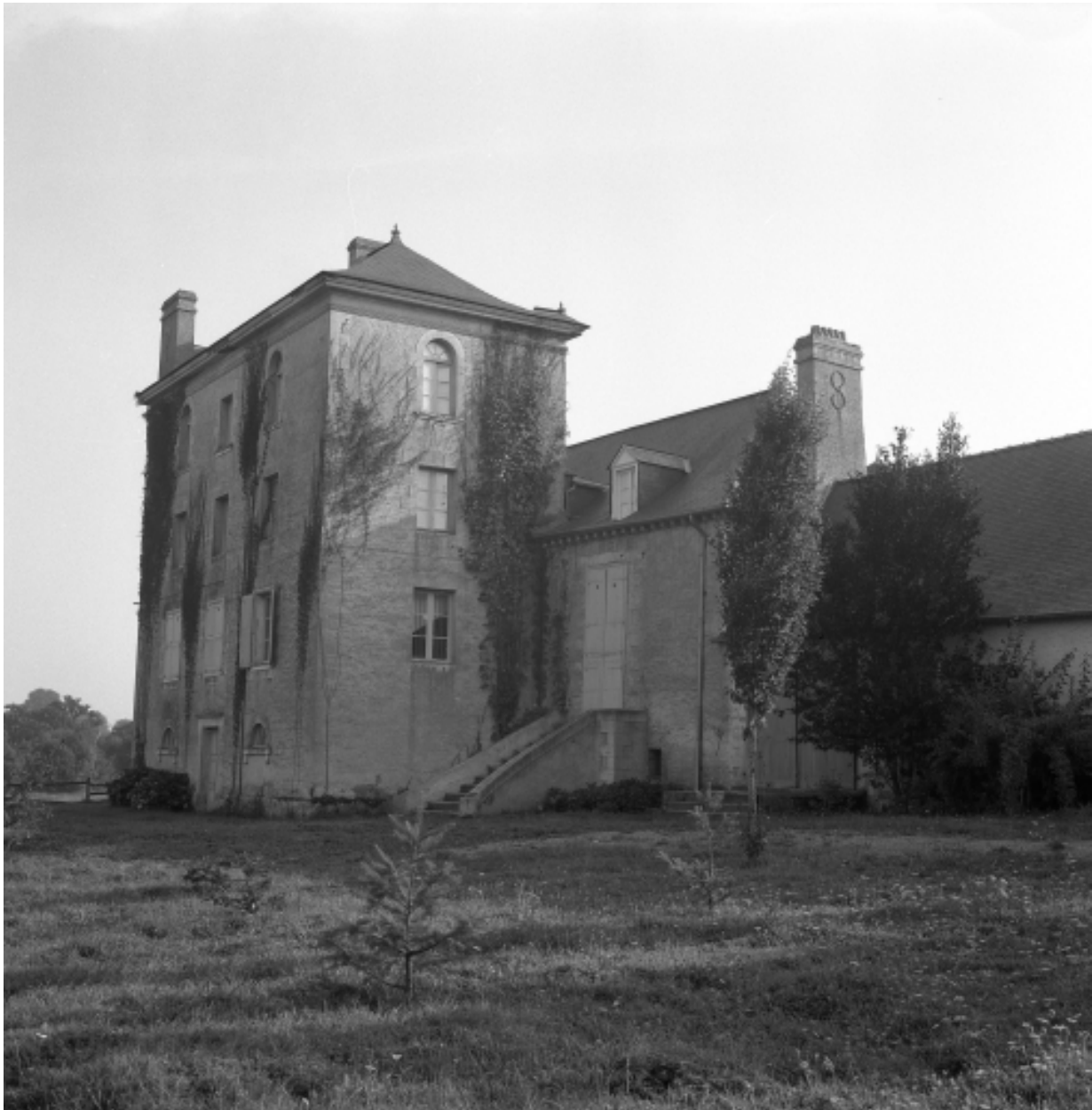
Corps de logis, vue nord est.
