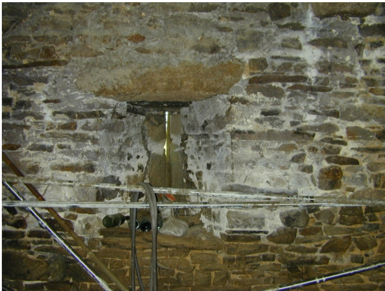
Intérieur, rez-de-chaussée, jour du cellier
