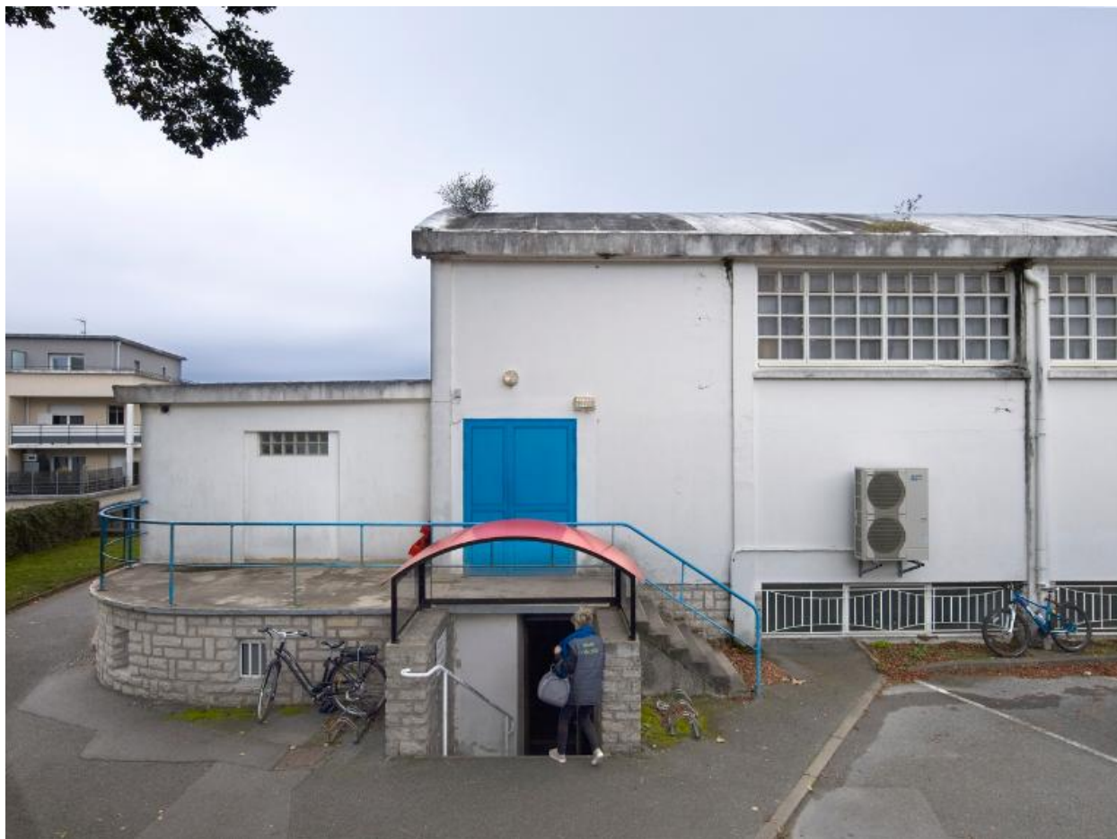
Angle sud-est du gymnase
