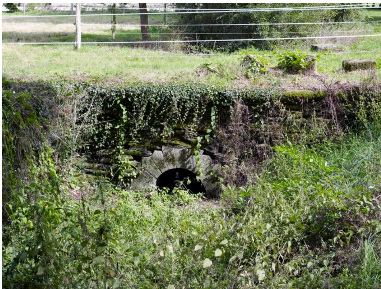
Château : ponceau sur les douves (état en 2010)
