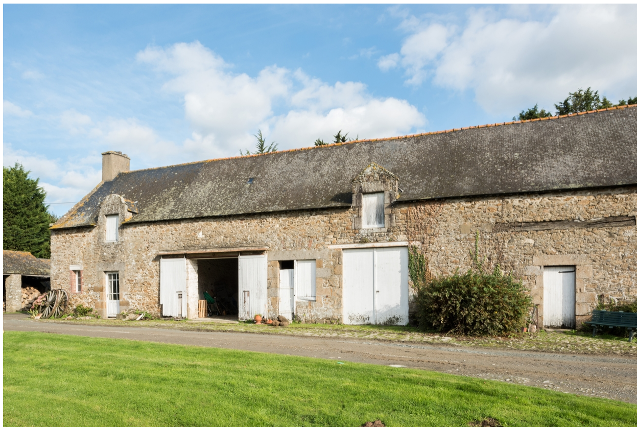
Les communs, vue générale depuis le sud
