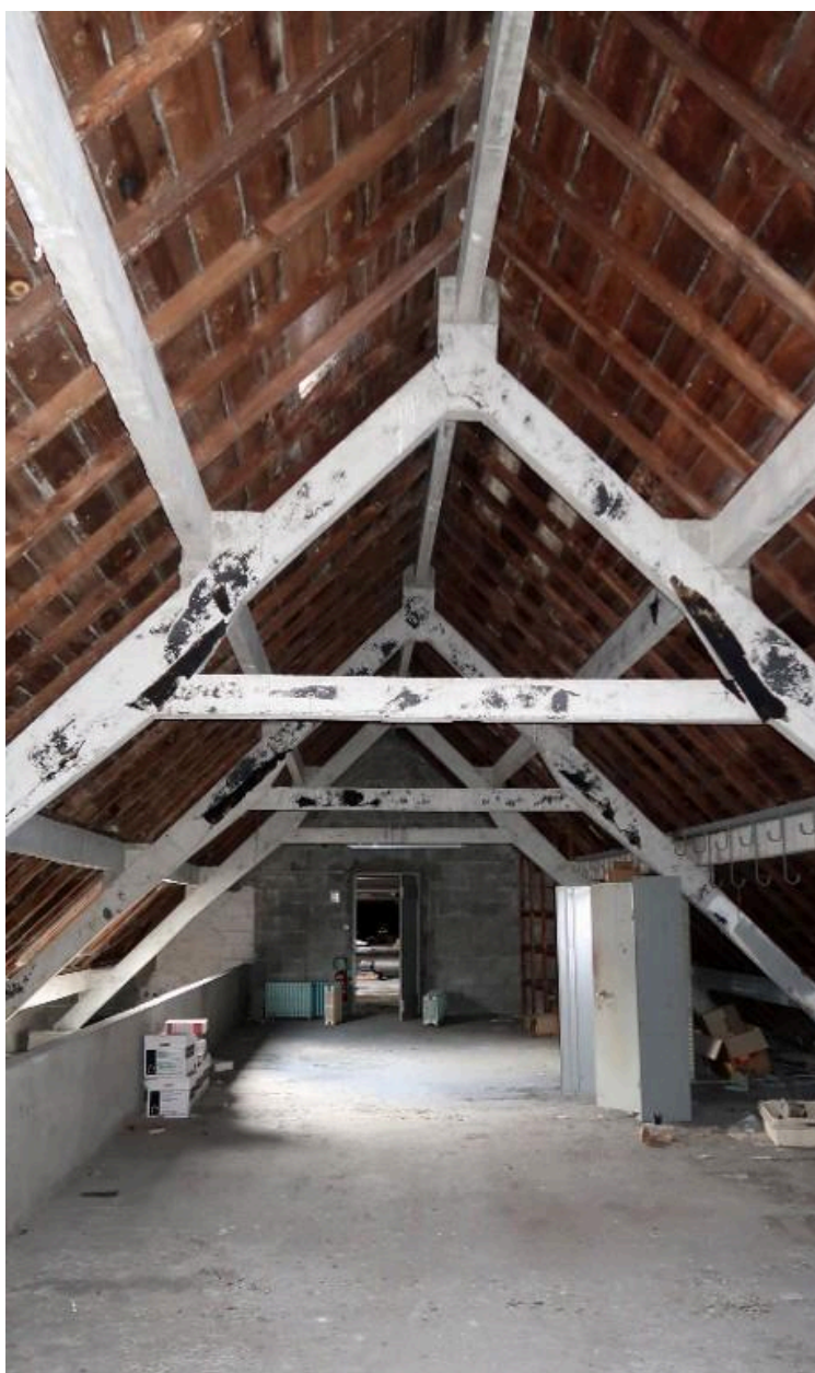
Criée de Concarneau : charpente béton
