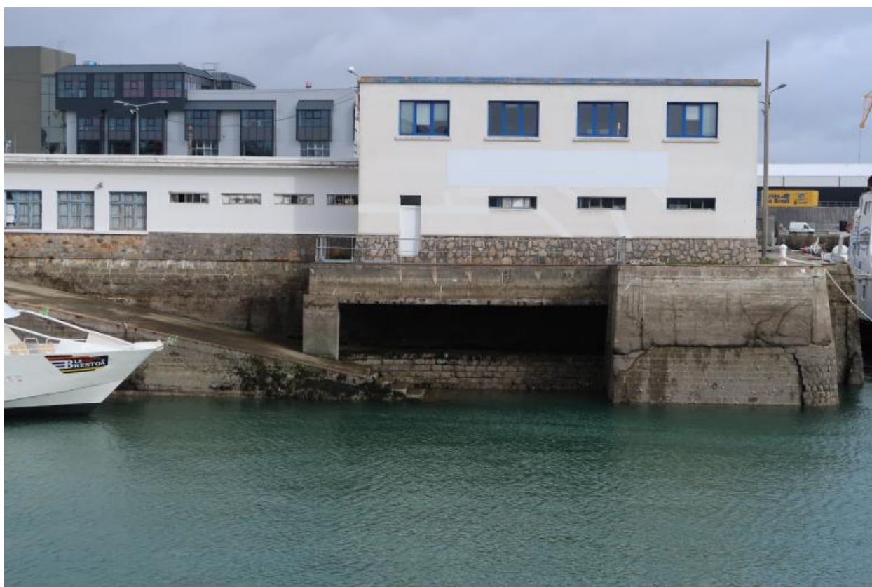
1er éperon, vue de la cale, du musoir et de la gare maritime
