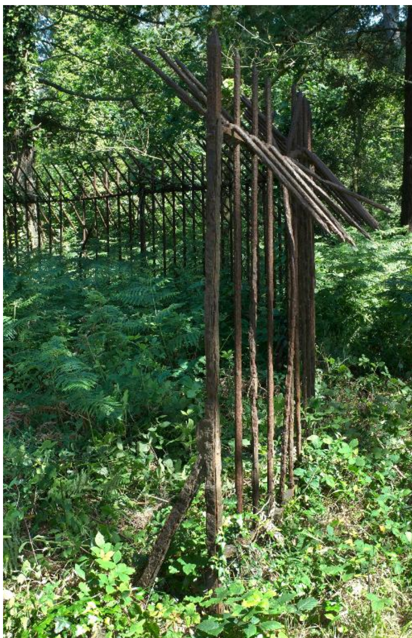
Vue des grilles défensives du magasin à poudre sous roc
