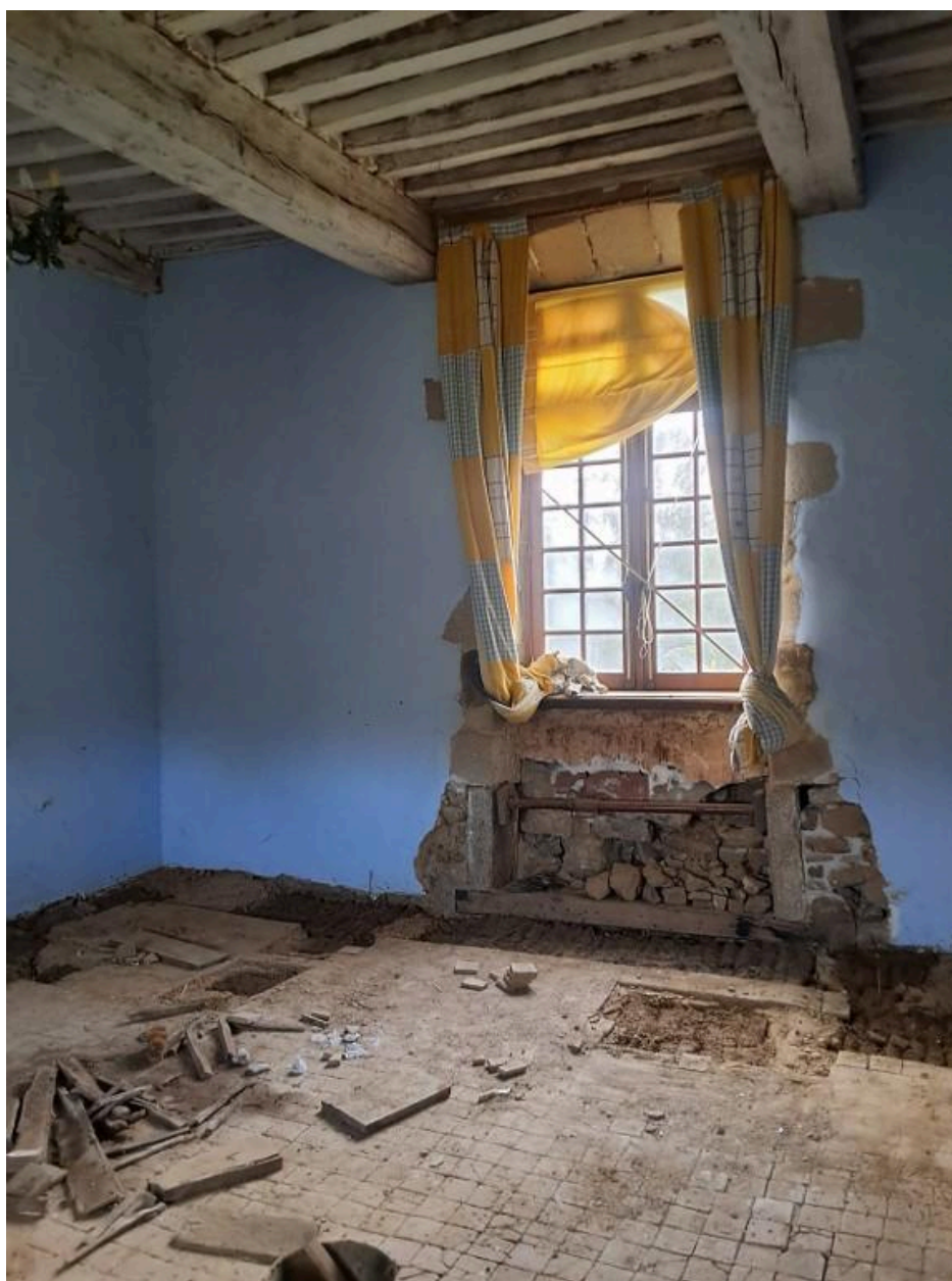
Premier étage, partie est, seconde salle à gauche de l'escalier
