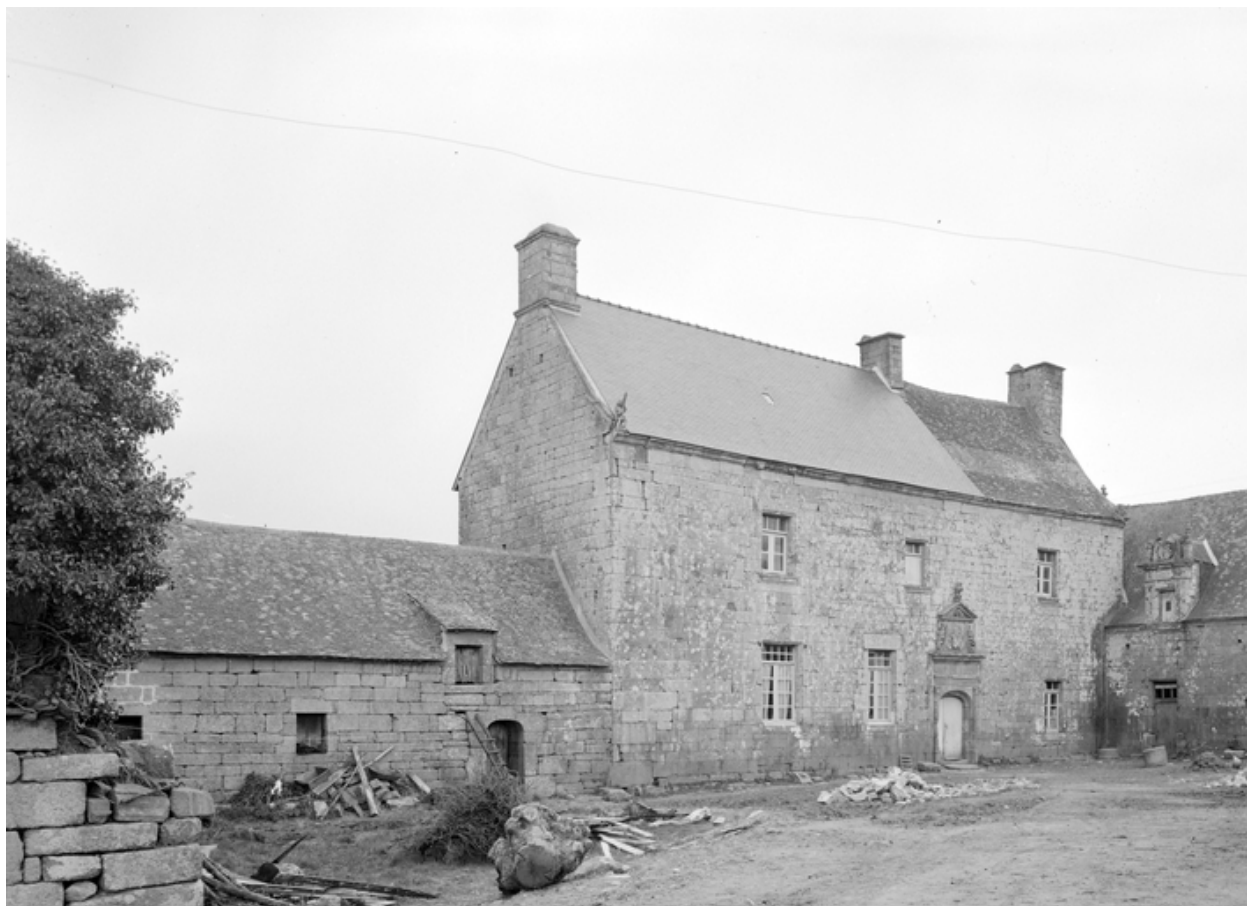
Vue d'ensemble des bâtiments, prise du sud-est.
