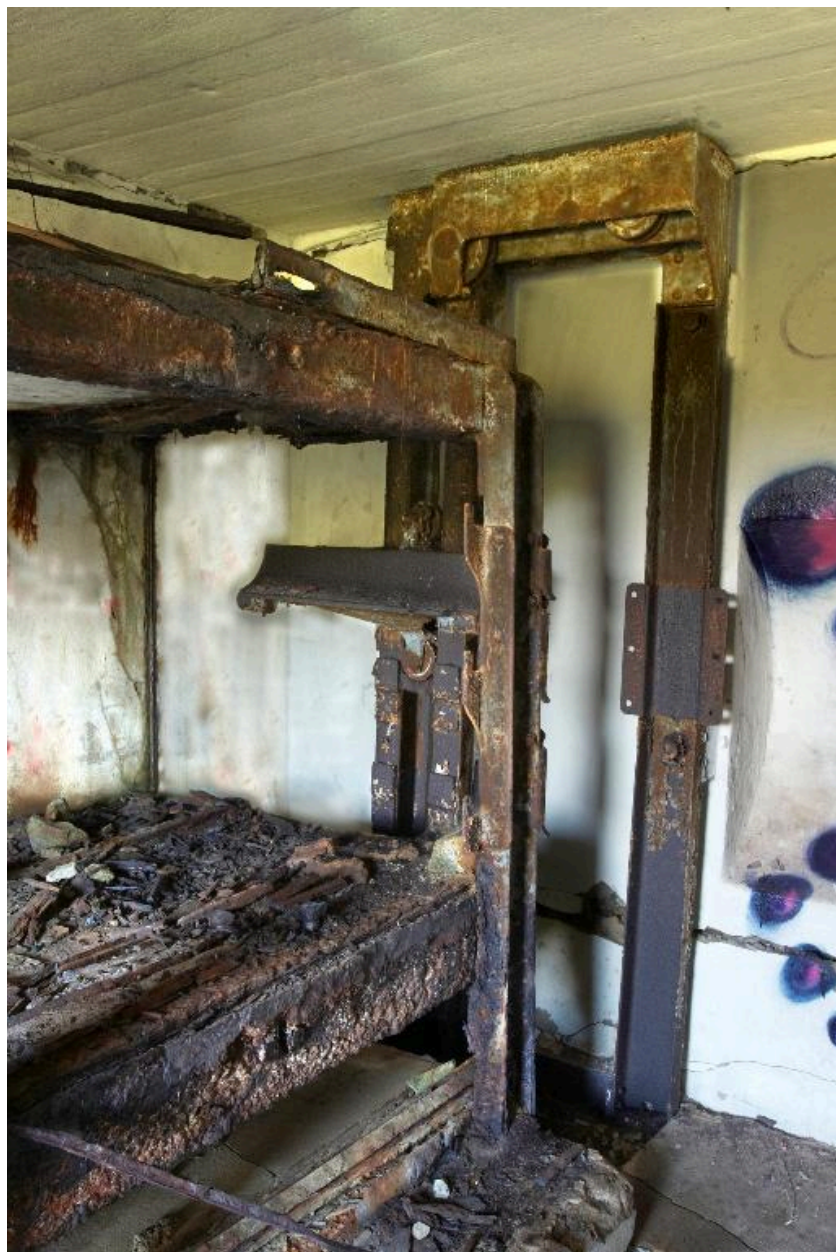
Vue intérieure de l'un des magasins de combat : étagère et monte-obus dans un compartiment à projectiles (état en 2009)
