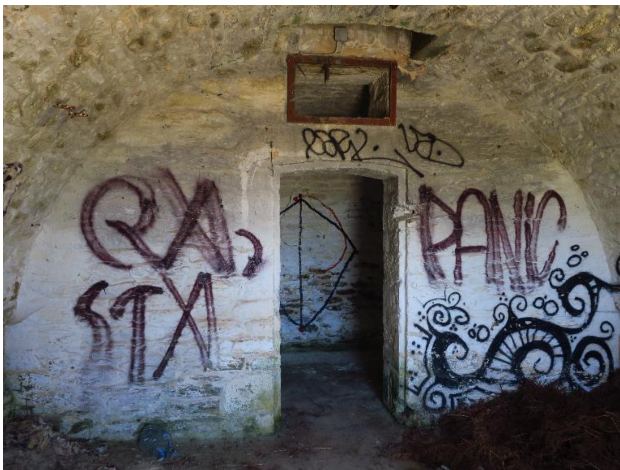
Groix, batterie du Bas-Grognon, traverse-abri, intérieur.
