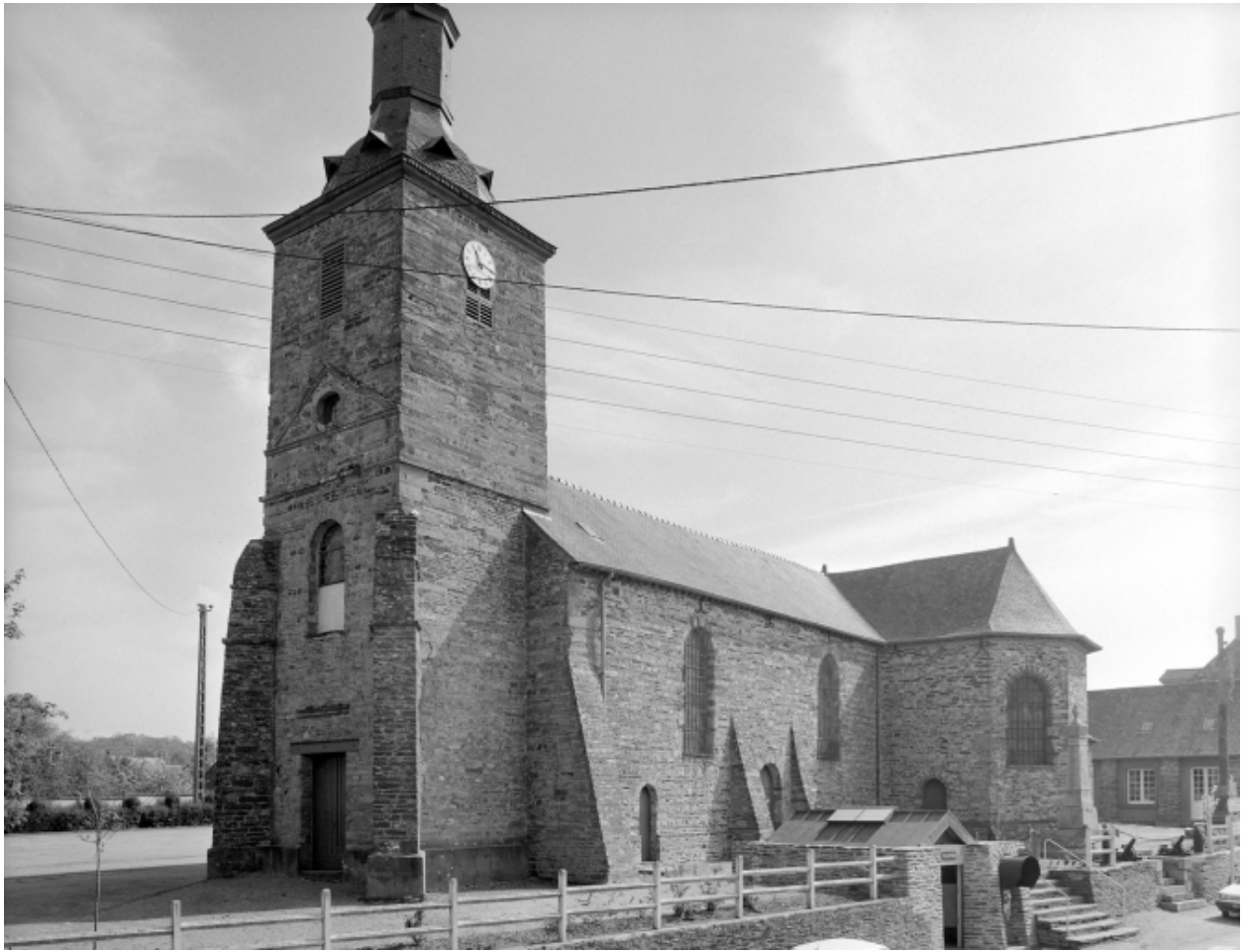
Elévation Sud-Ouest : vue générale
