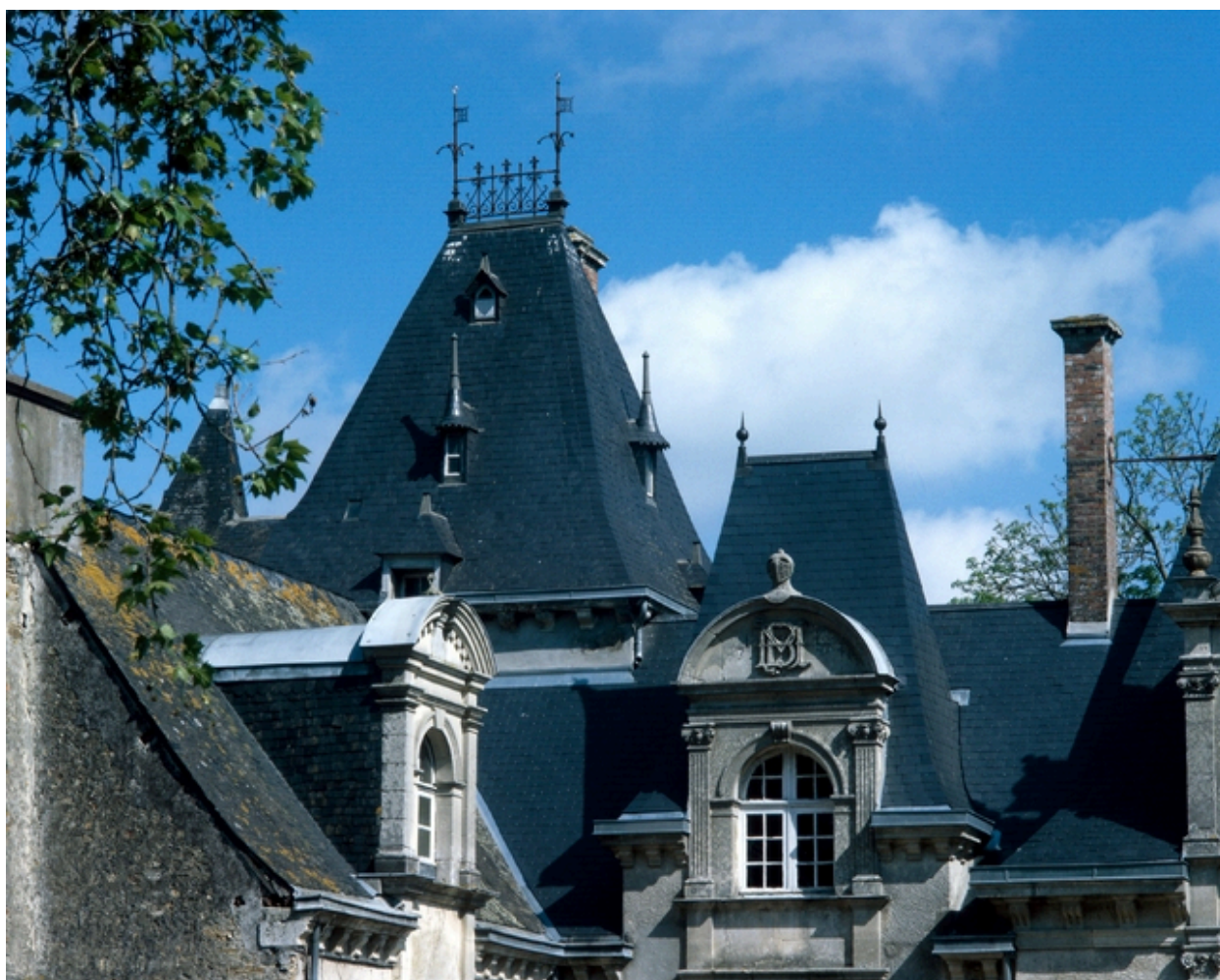
Vue générale des fenêtres sous toiture.
