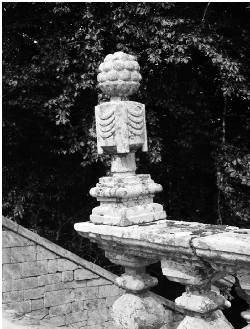
Terrasse, garde-corps : détail amortissement nord.
