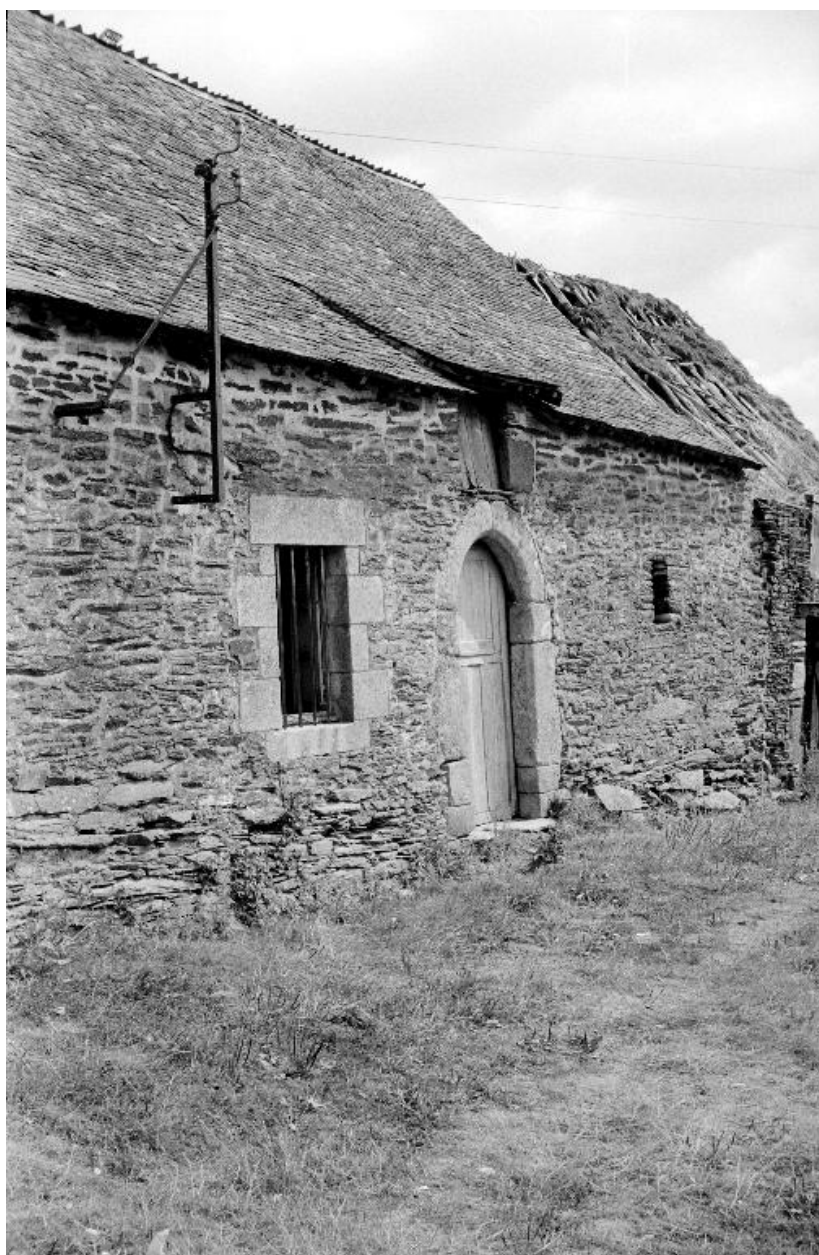
Ferme 37 (état en 1969)
